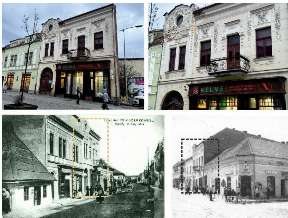
Figura 13 - Clădire – Strada Petofi Sandor nr. 2
