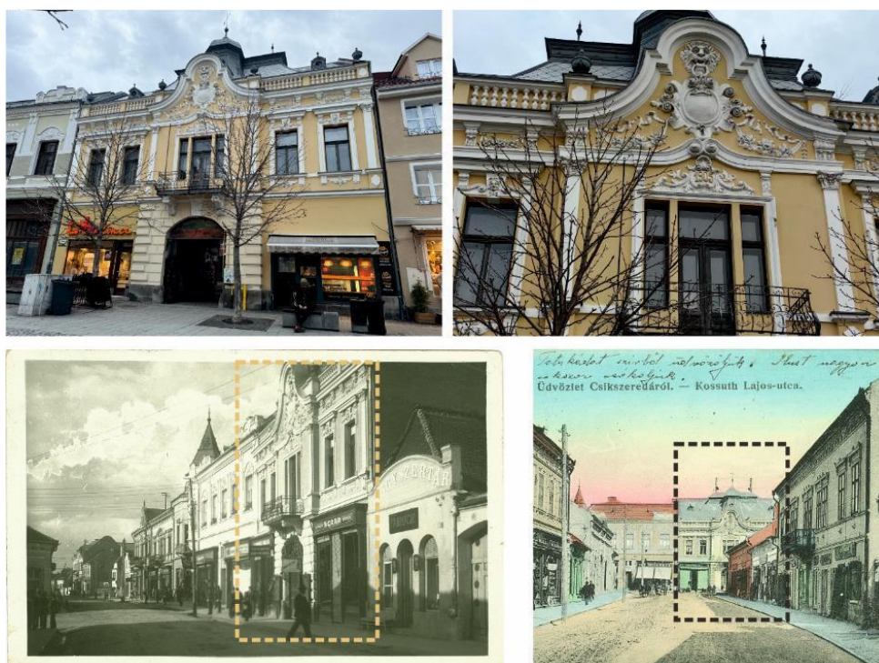
Figura 9 - Clădire – Strada Petofi Sandor nr. 3
